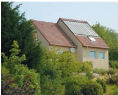
Maison individuelle à Besançon (Doubs) : 120 m 2 habitables, occupée par quatre personnes et 18 m 2 de capteurs en toiture (chauffage d'appoint intégré par chaudière électrique).
