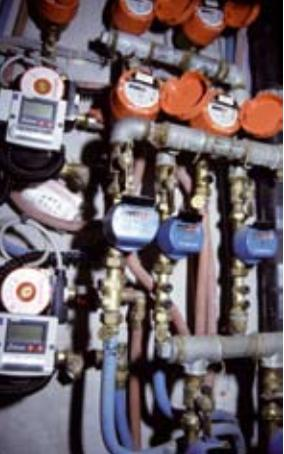
Armoire palière centralisant les compteurs de chauffage, d'eau chaude et d'électricité
