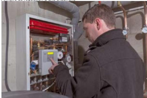
▲ Le **régulateur** est relié à **deux sondes de mesure de température** :
